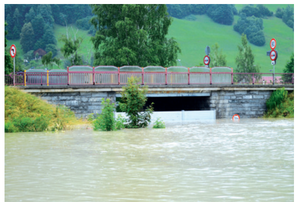
Unterführung Wennis, Foto: Manuel Kaltenhauser
